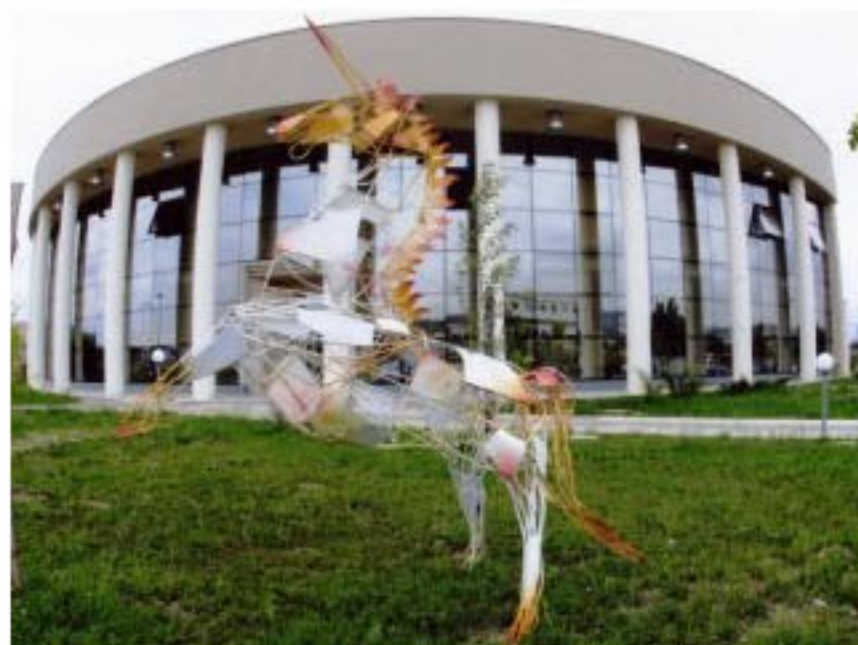
La sede del Consorzio ASI di Ponte Valentino
